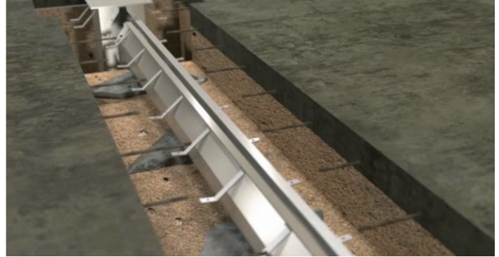
POUR SLURRY BELOW TO SECURE THE DRAIN
