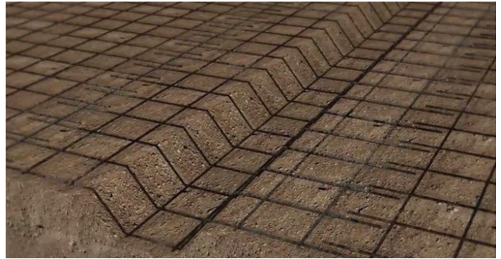
REBAR INSTALLATION BEFORE CONCRETE POUR
