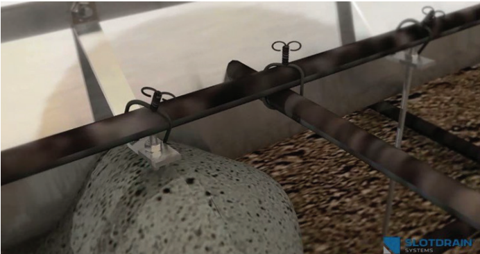
POUR SLURRY BELOW TO SECURE THE DRAIN
